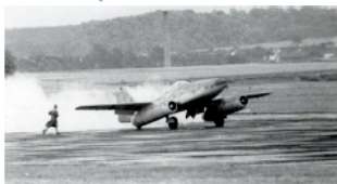
1943年、Me262試作機。生産型の前輪式ではなく後輪式であることに注意。
