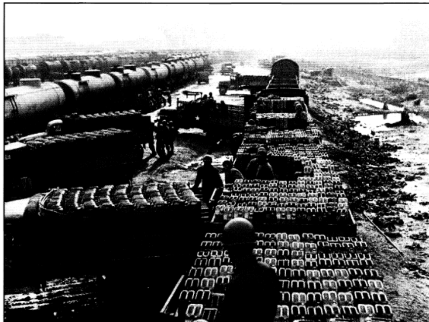
図46：アングルーキンカンボワ [Angleur-Kinkempois] [2704]にある巨大なリエージュの操車場燃料集積所での荷下ろし。鉄道タンクローリーから積み降ろされた後、各燃料トラックが5ガロン入りジュリ缶130本、都合650ガロンのガソリンを運ぶ。
